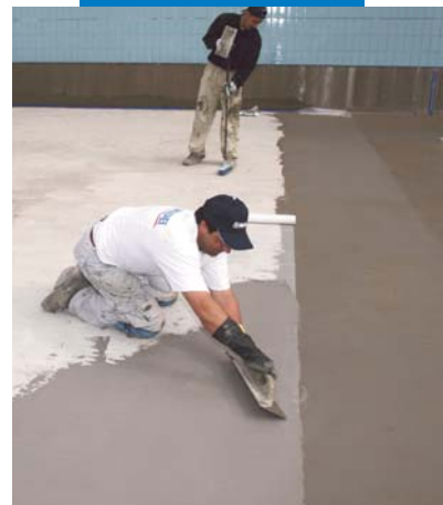
Impermeabilizzazione di una piscina con Mapelastic
