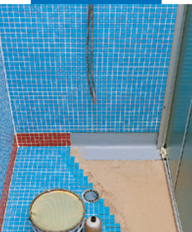
Impermeabilizzazione e posa in box-doccia prefabbricato
