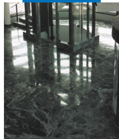
Pavimentazione in marmo verde Alpi realizzata nella hall di ingresso della Rolex (Bienne - Svizzera)
