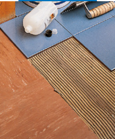
Posa su vecchi pavimenti in PVC
