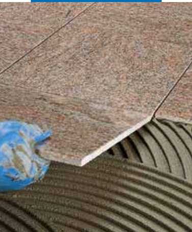
Posa di marmo prelevigato a pavimento
